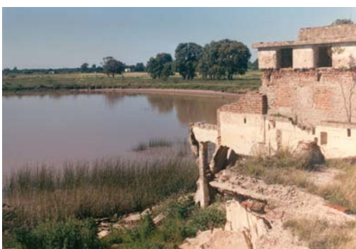
Fotografía 5. Antiguo Hotel Argentino de Punta Indio, totalmente destruido después del abandono que sufrió al ser afectado su predio por la erosión costera.
