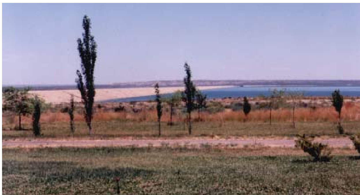
Figura 30. Dique Casa de Piedra.
