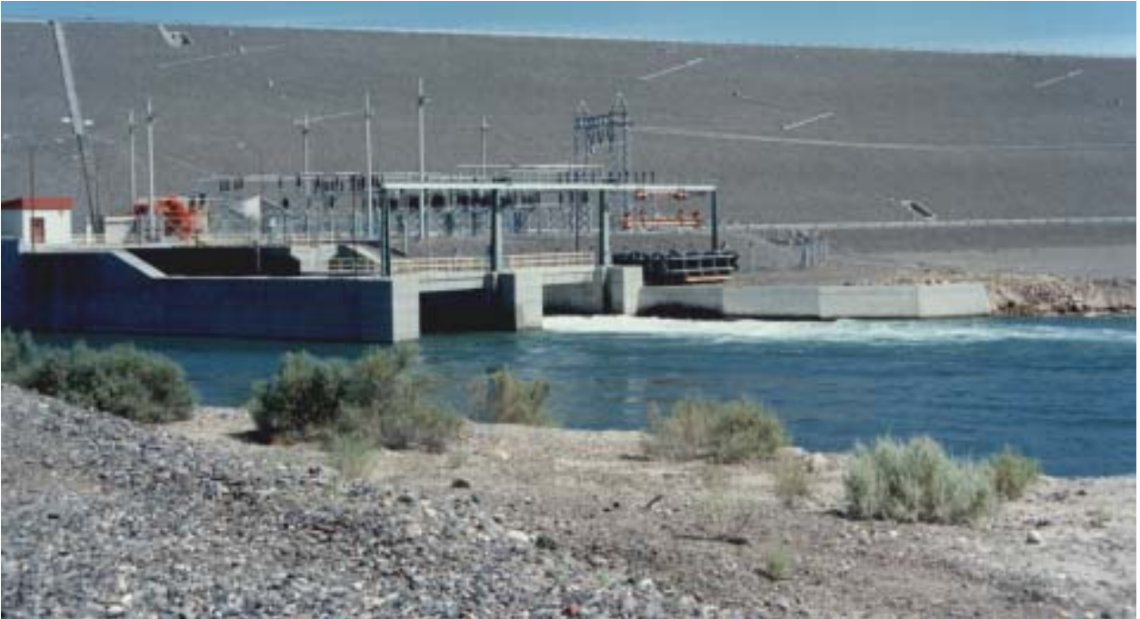
Figura 31. Instalaciones de monitoreo de la Central Hidroeléctrica de la presa Casa de Piedra.
