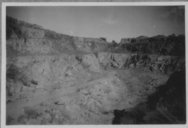
Fotografía Nº 1. - Vista de la cantera principal. Nótese los tres niveles y la vampa de acceso.-
