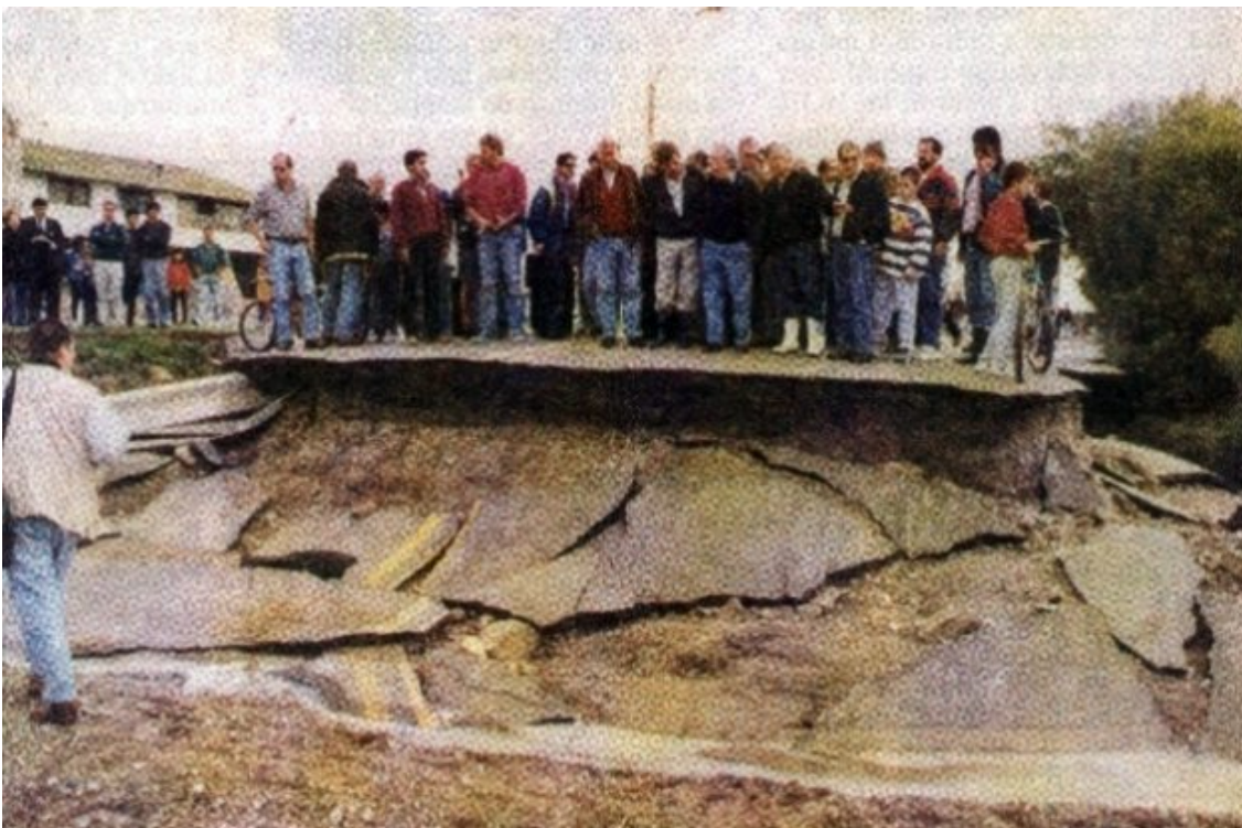
Rotura de la carpeta asfáltica en el sector del Boulevard Brown.
