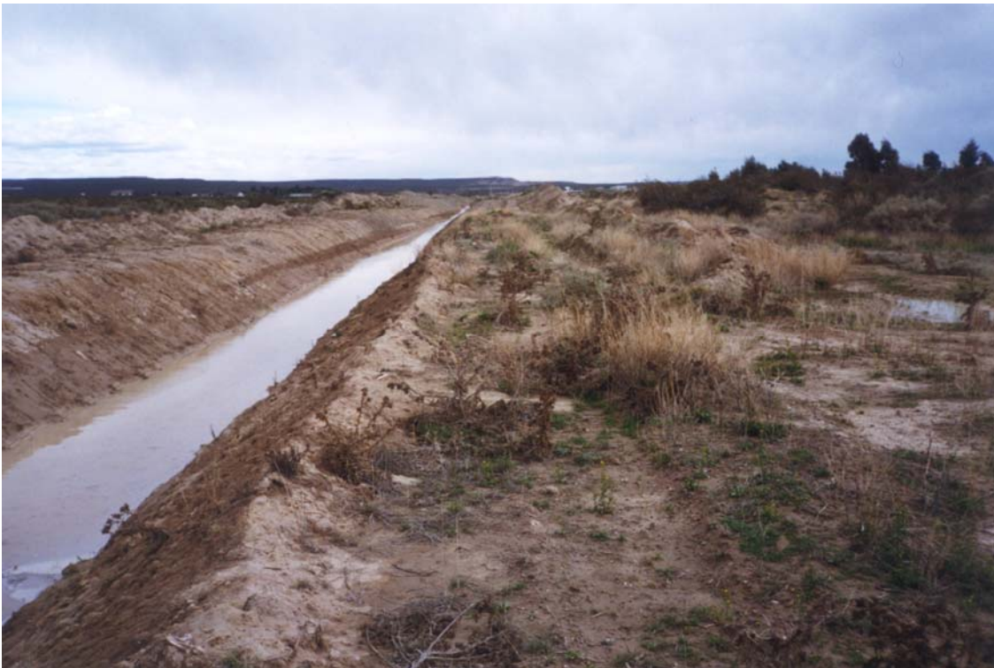
Obra de Defensa Hídrica denominada localmente Zanja de Guardia (pto C en el croquis obras de control de aluviones). La obra actúa como canal de captación y derivador de los escurrimientos laminares superficiales, de los niveles terrazados y de los caudales encauzados.
