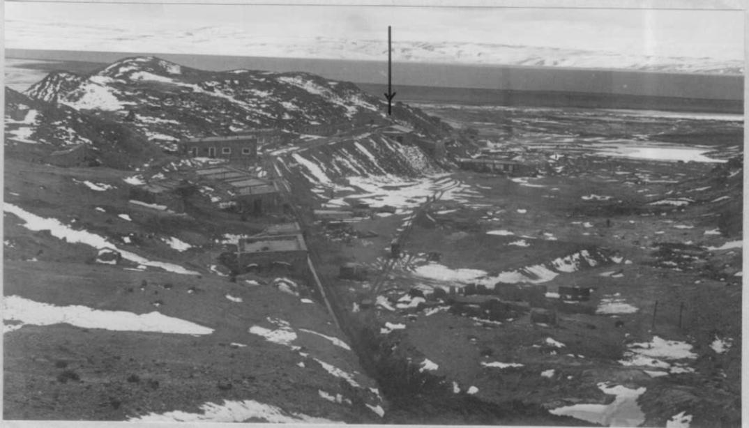
1.- Vista general del campamento y su planta de concentración. La flecha indica la usina donde se beneficia el mineral. En primer plano puede observarse la vía "decauville" que comunica con el socavón principal.-
