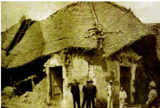
Figura 44. Destrucción total de las viviendas en la ciudad de Pelileo afectada por el terremoto de 1949.
