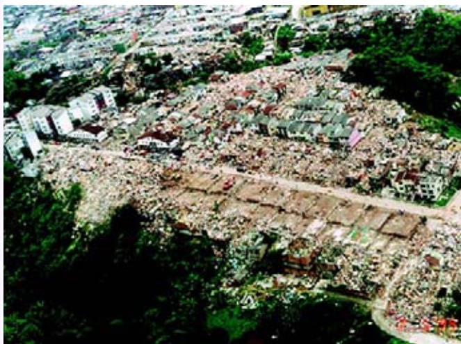
Figura 42. Vista aérea de la destrucción originada por el terremoto del 25 de enero de 1999.
