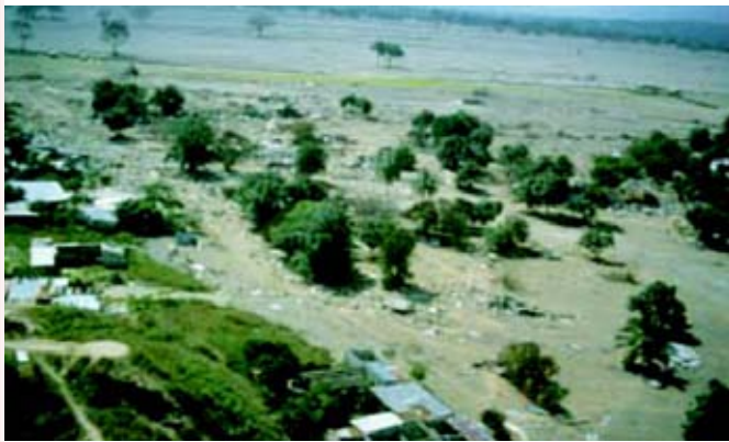
Figura 63. Vista de detalle de Armero luego del paso del lahar.
