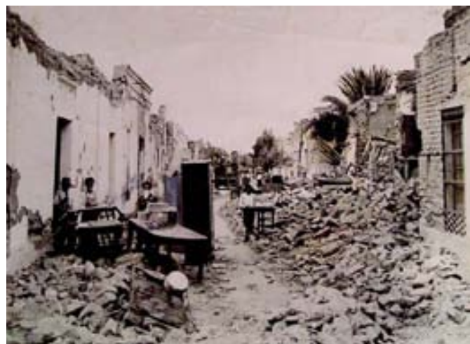
Figura 50. Daños de casas de la ciudad de San Juan por efectos del terremoto de 1944.
