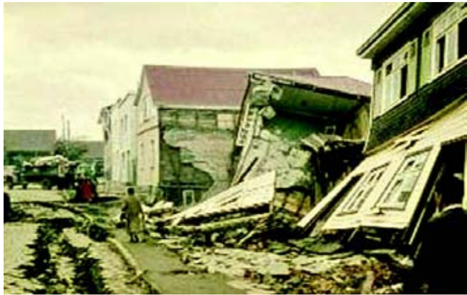
Figura 48. Daños en viviendas de Valdivia.
