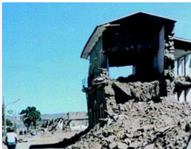
Figura 47. Casas destruidas en Aiquile.
