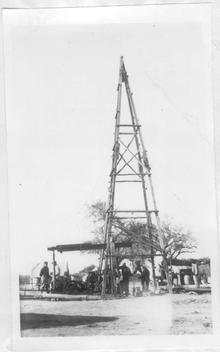
23.958-Prov. de La Rioja. El equipo perforador de Pa- lo Labrado.-
