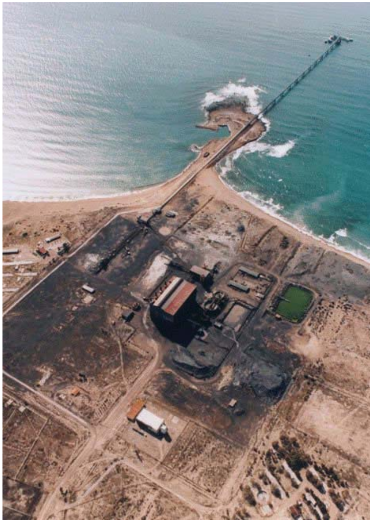
Fotografía 3. Vista aérea de la planta de pelletización y del embarcadero en punta Colorada (tomada de Guillermo Benitez, www.sierragrande.tripod.com.ar ).
