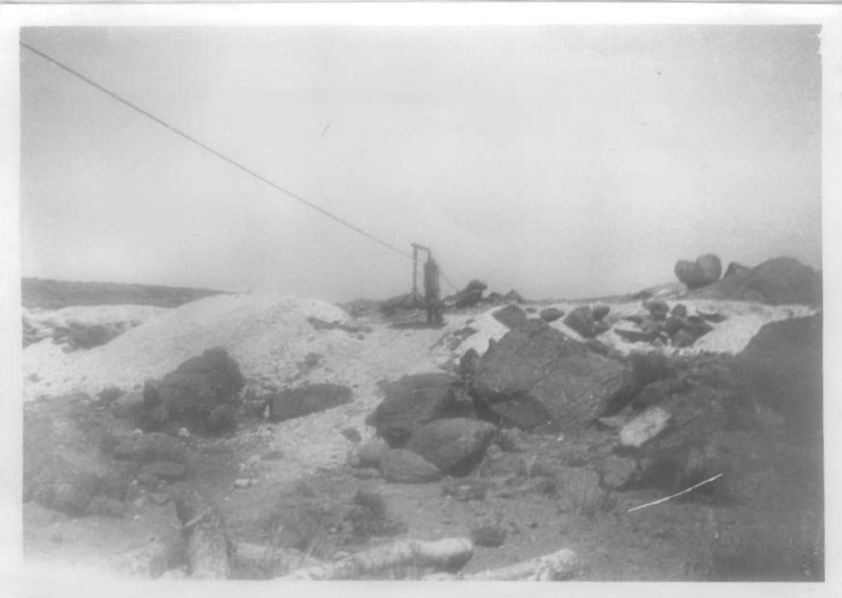
Cable-carril sobre el Río Agrío para transporte de baritina de la mina "La Constancia"
