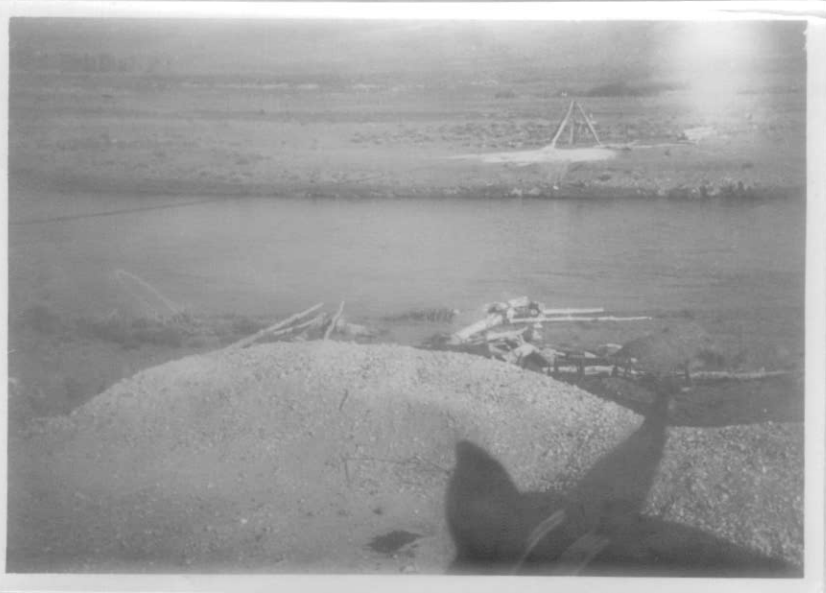
Vista del Río Agrío-Cable-carril para transporte de baritina de la mina "Rosita"
