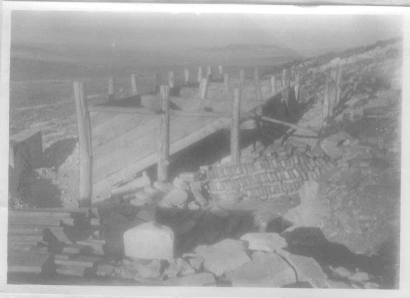
Calera "Los Catutos"-silos para acopio de piedra partida para cocción.
