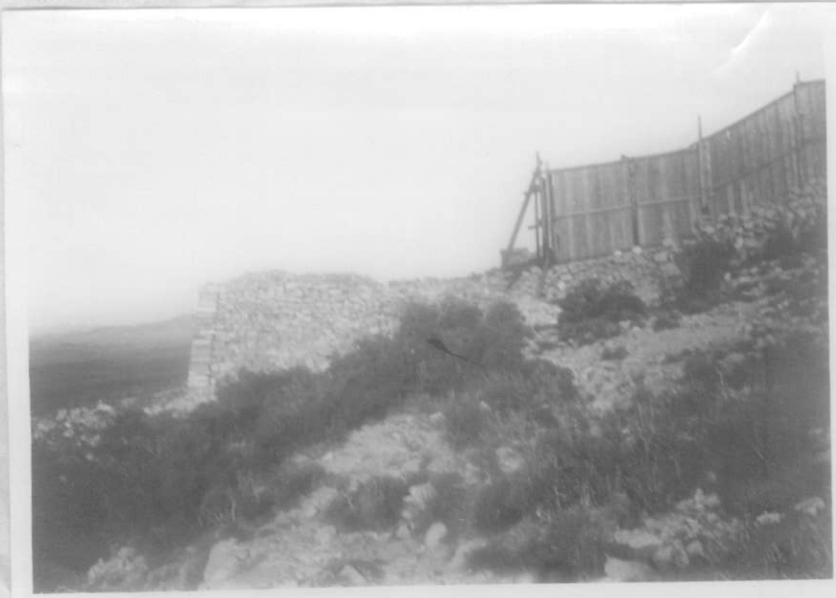
Calera "Los Catutos"-Horno de piedra para cocción y silos.
