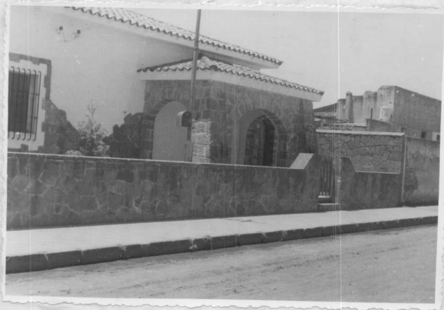
Fig. 2.- Frente de una casa en la ciudad de Mercedes con revestimiento de Arenisca.
