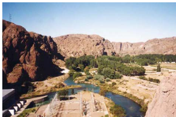
Figura 2. Mantos de ignimbritas riolíticas de la Formación Marifil en el valle del río Chubut (Villa y usina del dique Florentino Ameghino), con su típica presentación como paredones abruptos subverticales.
