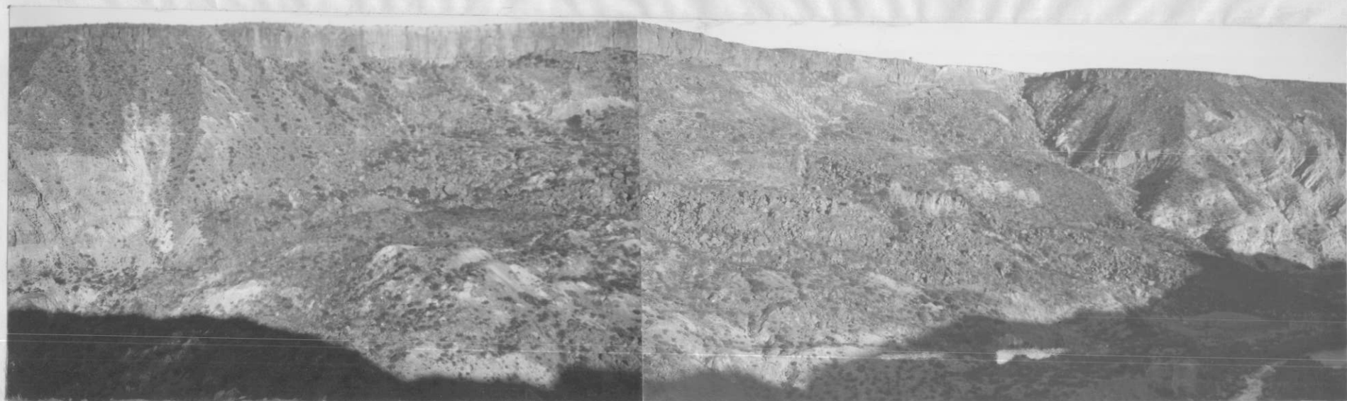
Fot. 6.- Barranca derecha (sur) del Río Atuel, mostrando un importante deslizamiento de falda que ha alcanzado la vaguada del río y es cruzado por éste con formación de rápidos.-
