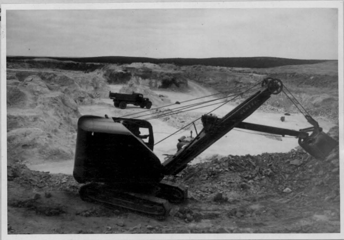
Foto 1.- Vista de la cantera N° 3. En primer plano excavadora mecánica despejando la cubierta estéril.
