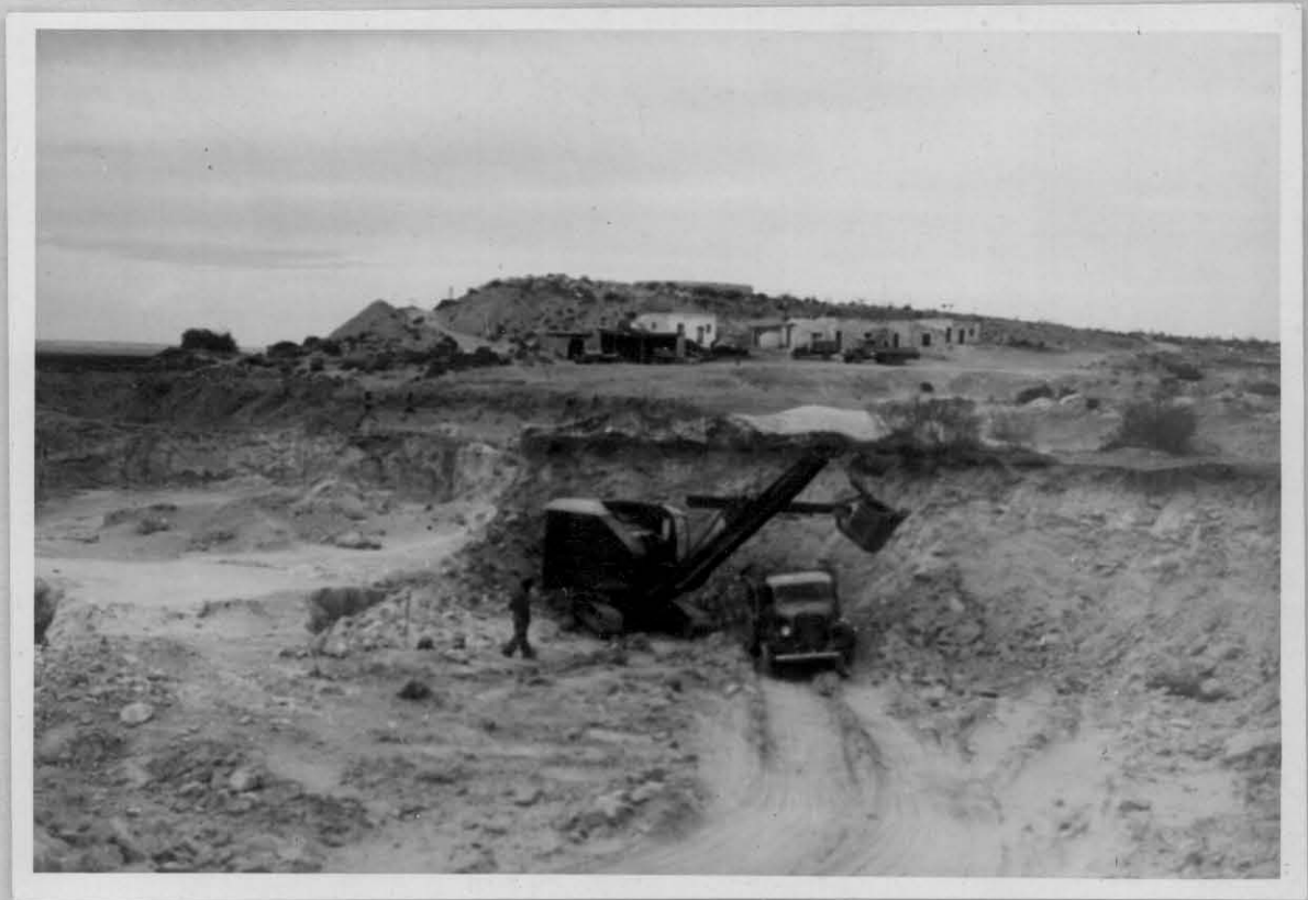
Foto 1.- Vista de la cantera N° 3. En primer plano excavadora mecánica despejando la cubierta estéril.
