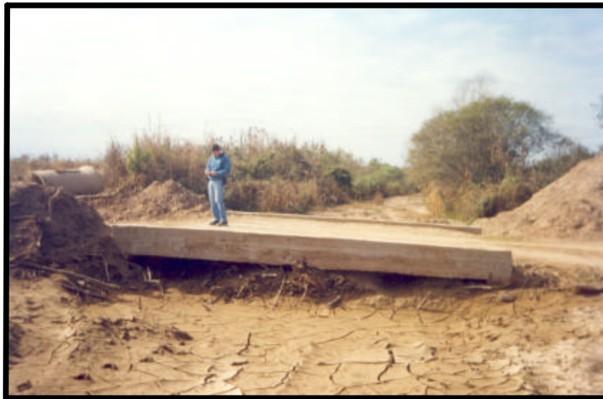
Foto N° 11: Canal colmatado por material de textura limosa a arenosa fina al costado de la ruta provincial 334 que conecta las localidades de La Cocha con Taco Ralo.
