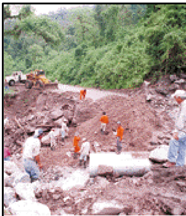
Foto 16: Reparación de la ruta 307, en la Quebrada del Río Los Sosa, luego de las lluvias del 2001 (fotografía diario La Gaceta).
