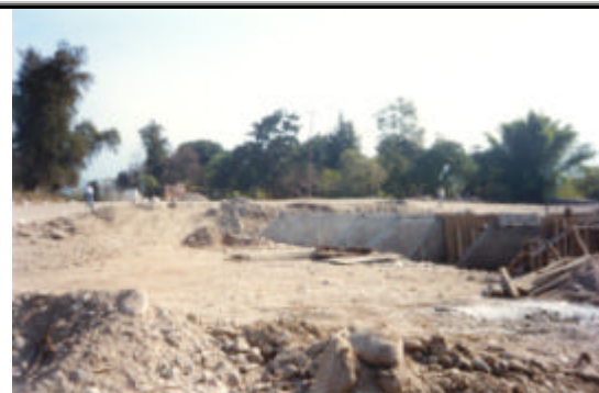
Foto 9: Construcción de un nuevo puente sobre el río Zerda, en la ruta 307.
