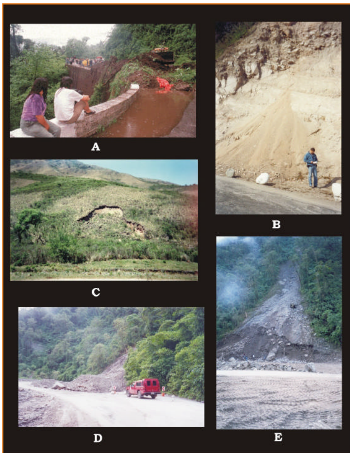
Figura 13: A. Deslizamiento de tierra en el angosto del Naranjal, ruta 307. B. Deslizamiento espontáneo sobre material arenoso seco en la ruta 307. C. Deslizamiento rotacional sobre material loesico en el valle de Singuil. D. Vista de costado de un cono de detritos parcialmente removido, originado por avalancha de detritos sobre la ruta 307. E. Vista de frente del gran cono de detritos que tuvo lugar en la zona de Playa Larga, sobre la ruta 307.
