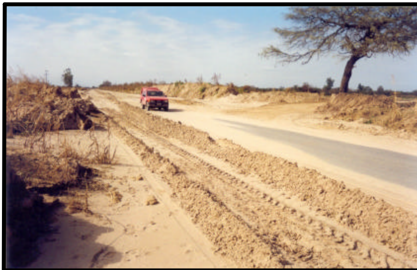
Foto N° 12: Tramo de 1,5 km de la ruta 334 que fuera cortada por la gran cantidad de material fino depositado por los arroyos El Sueño y La Posta.
