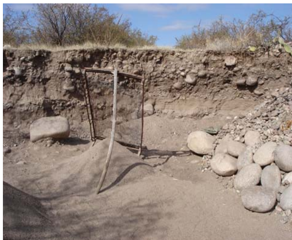
Figura 12: Extracción artesanal de áridos en el cauce del río Cruz del Eje, próximo a El Brete.
