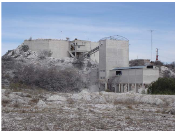
Figura 29: Planta de tratamiento del polo productivo de Canteras Quilpo.
