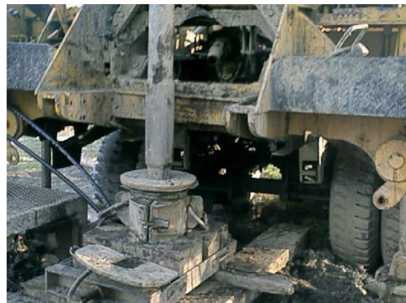
Imagen N° 7. Cepo, mordaza y platina previamente al engravado. Las dos mangueras negras a la izquierda de la platina son los piezómetros
