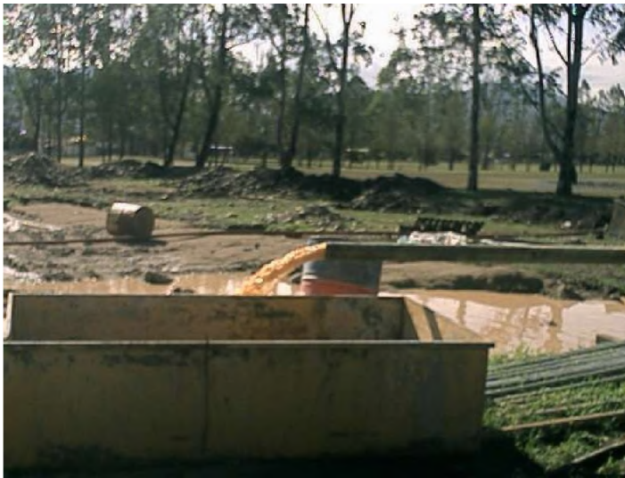
Imagen N° 11. Primeros instantes de bombeo. Agua turbia. En la parte inferior de la fotografía se observa una de los piletones usados en la preparación de la lechada de cemento y para la medición de caudales de bombeo
