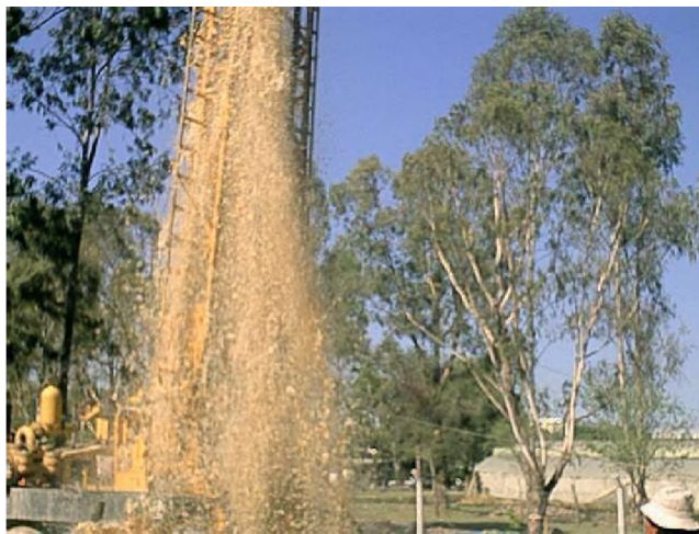
Imagen N° 8. Columna de agua durante la limpieza con aire comprimido.
