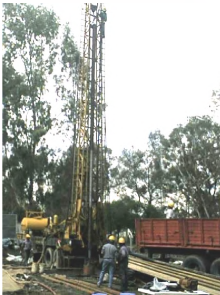
Imagen N° 6. Operación de entubación
