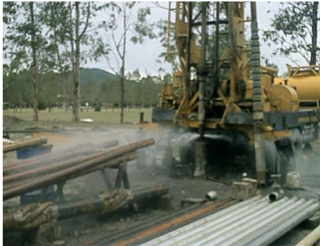
Imagen N° 10. Prueba del jet en superficie.
