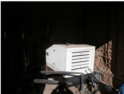
Grupo electrógeno comprado con el subsidio, en el campamento de Salinas Grandes, junio de 2009.-
