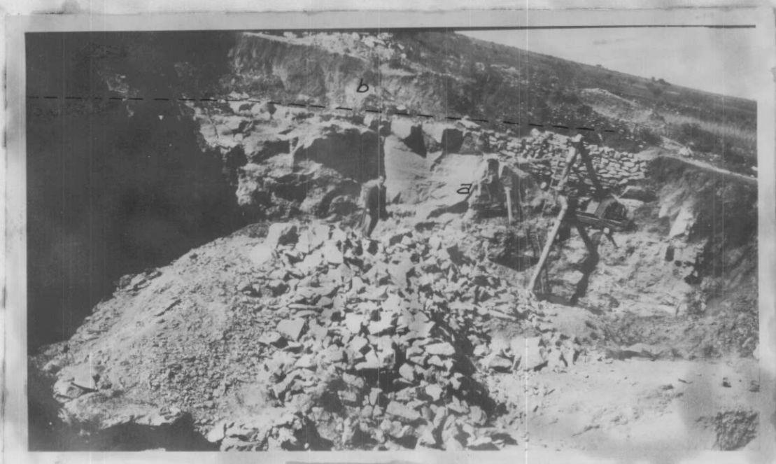
Fig. 7 - Cantera "Constantini", (Curuzú Cuatiá). a) banco calcáreo en explotación (Mioceno). b) sedimento arcillo-arenoso (greda pliocena).
