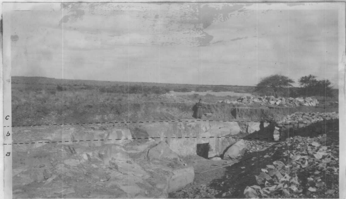
Fig. 4 - Cantera "La Quemada" (Paso de los Libres). a) arenisca triásica; b) arenisca pliocena; c) suelo vegetal con restos del aglomerado pleistoceno.
