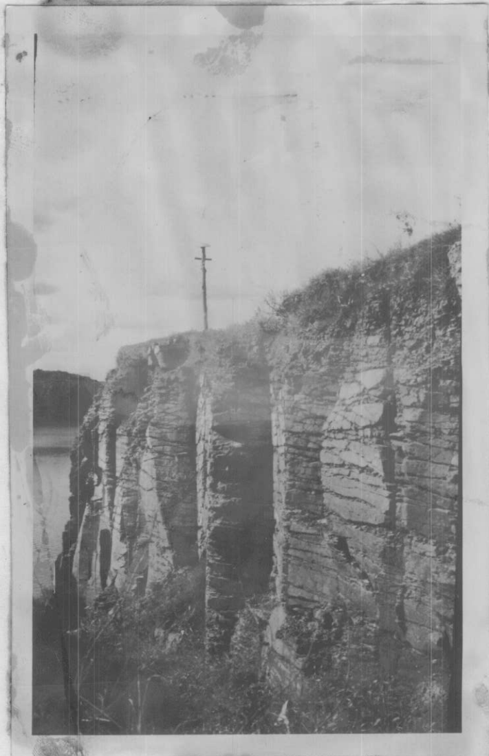
Fig. 3 - Cantera "La Cautiva" (Curuzú Cuatiá) Rocas basálticas muy fracturadas, utilizables como materiales de construcción en general.
