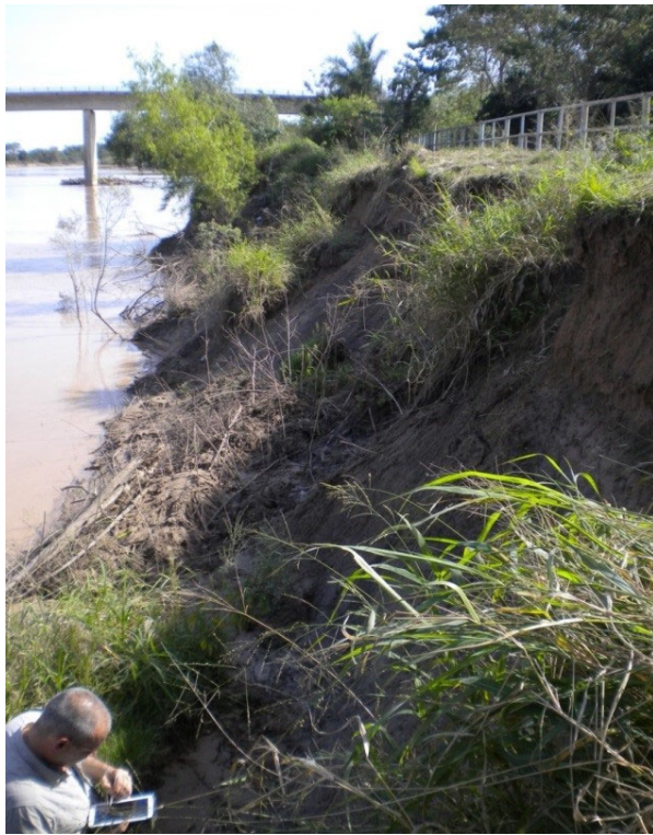
Figura 9. Barrancas del río Bermejo a la altura de El Colorado, al fondo el puente de la ruta nacional 95.
