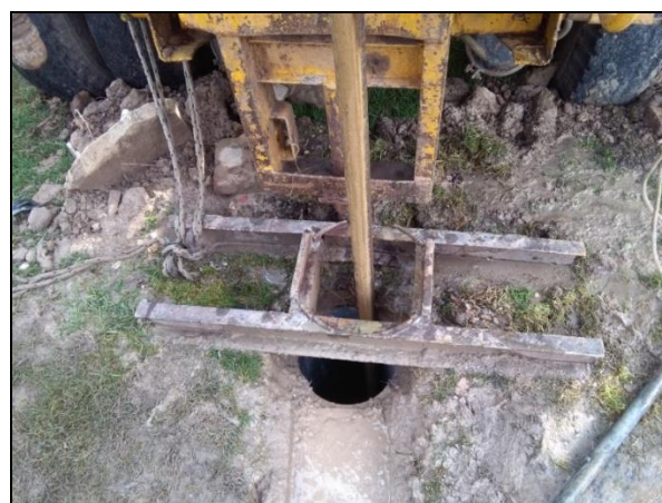
Fotografía 3.2: Detalle de boca de pozo.
