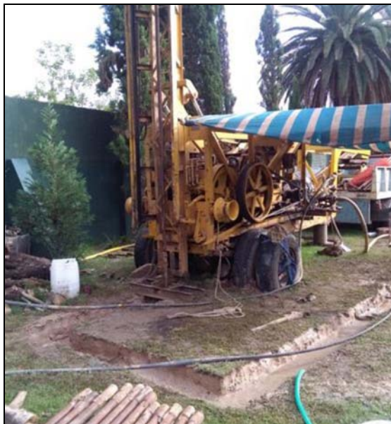
Fotografía 3.1: Perforadora utilizada y locación.
