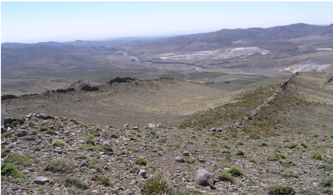
Figura 37. Vista hacia el sur del Complejo Diques Calle del Yeso. En segundo plano la Formación Auquilco en el sinclinal La Valenciana.
