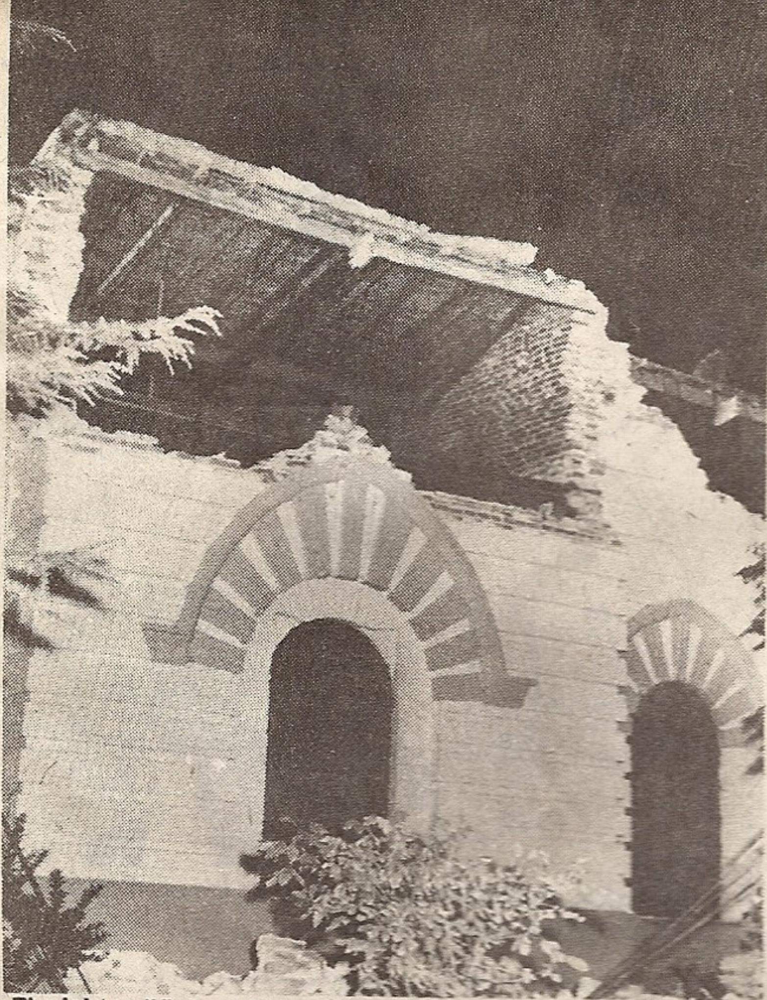
El viejo edificio del Hospital El Carmen, construido en 1895 fue prácticamente destruido por el terremoto de ayer.
