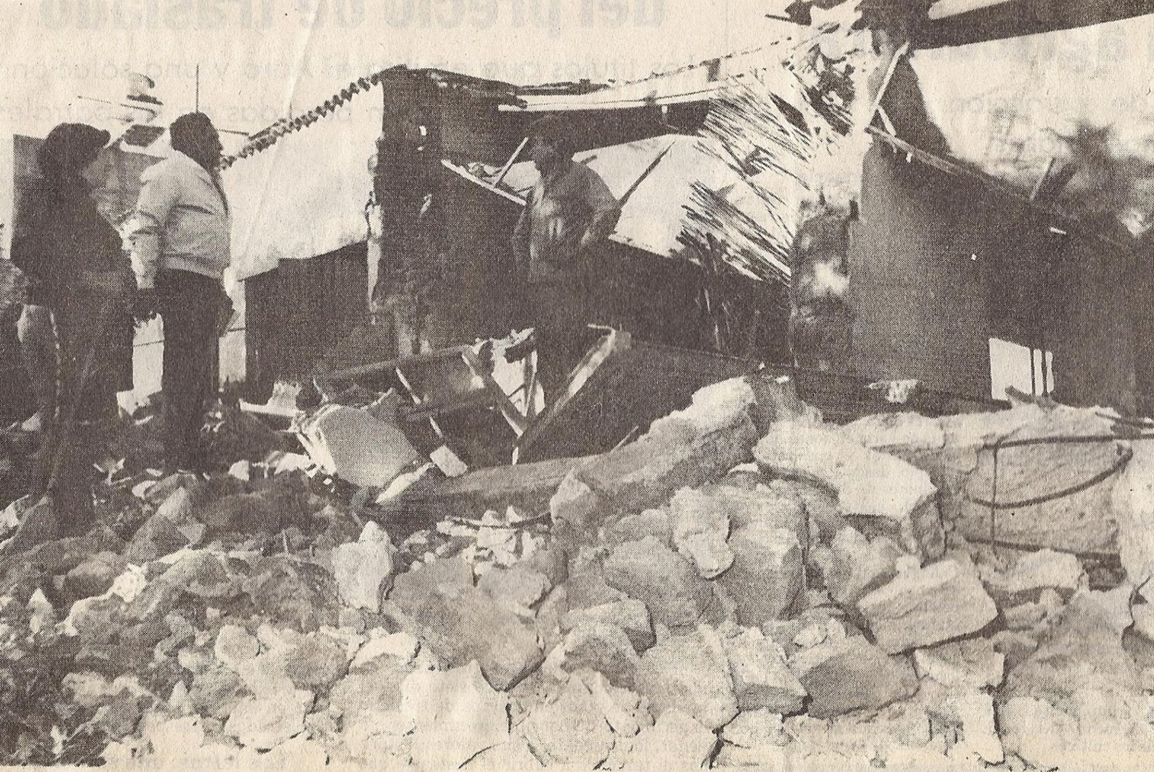
Los daños en las viviendas son cuantiosos. Las denuncias en Godoy Cruz y Las Heras suman miles.
