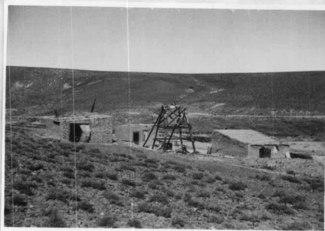
Torre de Extracción-Pique Principal
